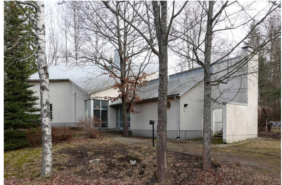
Rakennus kuvattuna länsipuolelta. Kuva: Juho Saloheimo, Vantaan kaupunginmuseo 2025.
