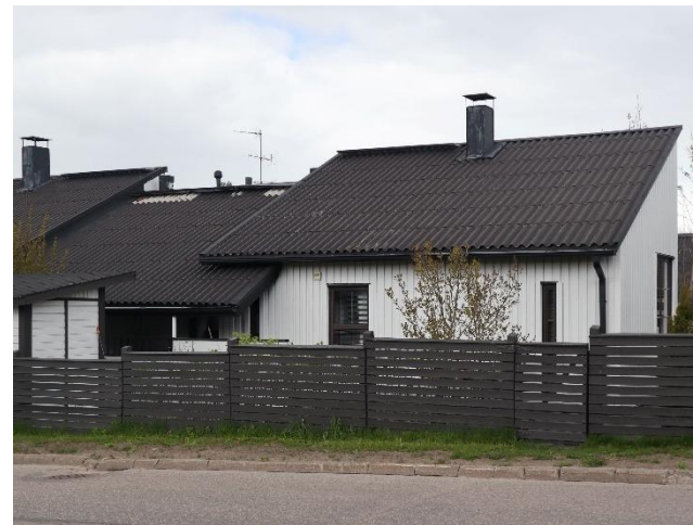
Rakennus 2 kuvattuna etelästä. Kuva: Kristian Tuomainen, Vantaan kaupunginmuseo 2025.
