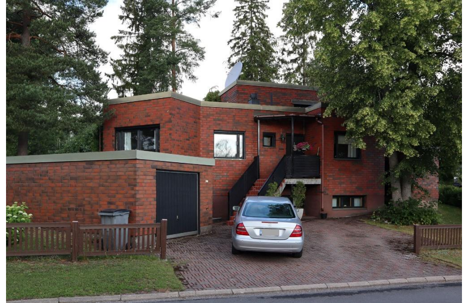
Pääjulkisivu kuvattuna Uudentuvantieltä. Kuva: Johannes Vihervirta, Vantaan kaupunginmuseo 2023.
