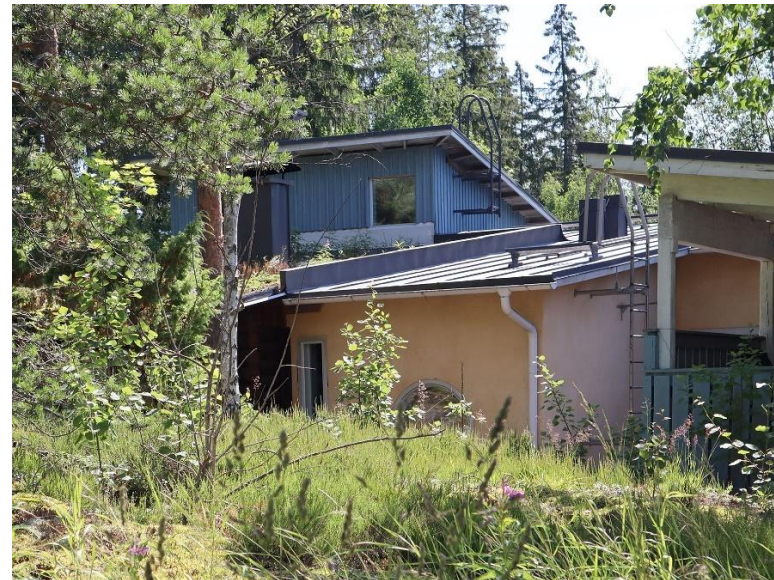
Rakennus 1:n luoteista julkisivua kuvattuna Aurinkomäentieltä. Kuva: Kristian Tuomainen, Vantaan kaupunginmuseo 2025.
