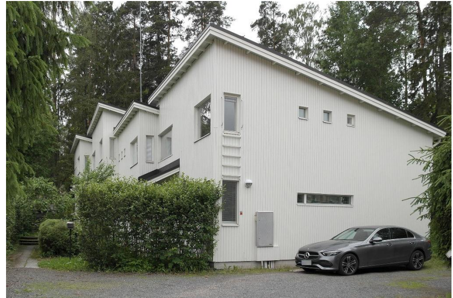
Rakennus kuvattuna pohjoisesta. Kuva: Venla Härmä, Vantaan kaupunginmuseo 2025.
