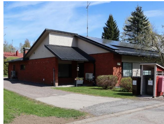
Hakatie 9, Ilola, 1980. Vielä 1980-luvullakin rakennuksiin tehtiin tasakattoja. Tasakattoja kuitenkin vaihdettiin kalteviksi, kuten kuvan rakennuksessa tehtiin vuonna 1989. Kuva: Kristian Tuomainen, Vantaan kaupunginmuseo 2025.
