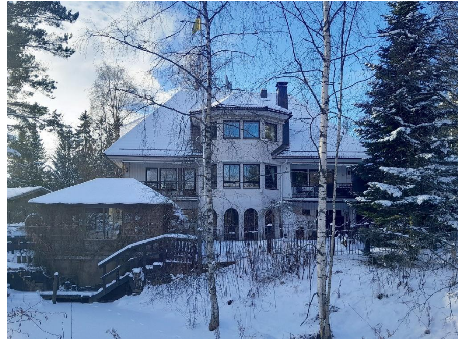
Idän puolen julkisivu avautuu Keravanjoen rantamaisemaan. Kuva: Juho Saloheimo, Vantaan kaupunginmuseum 2025.
