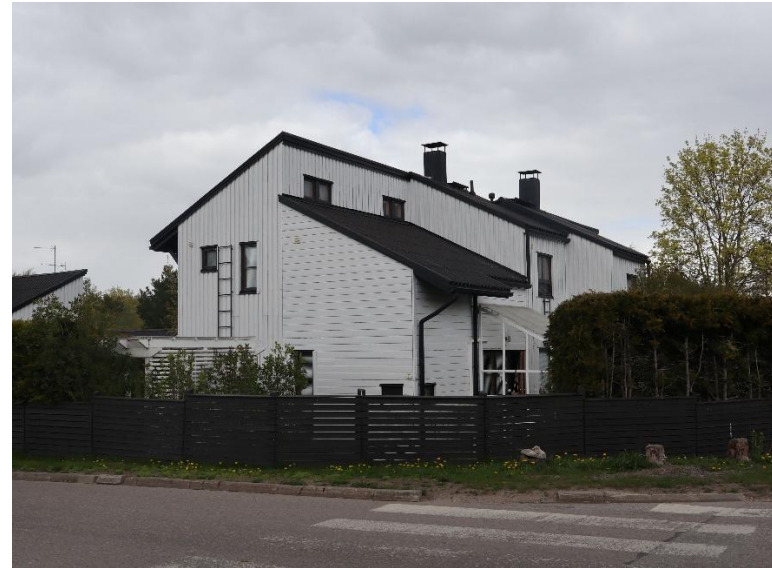
Rakennus 3 kuvattuna etelästä. Kuva: Kristian Tuomainen, Vantaan kaupunginmuseo 2025.
