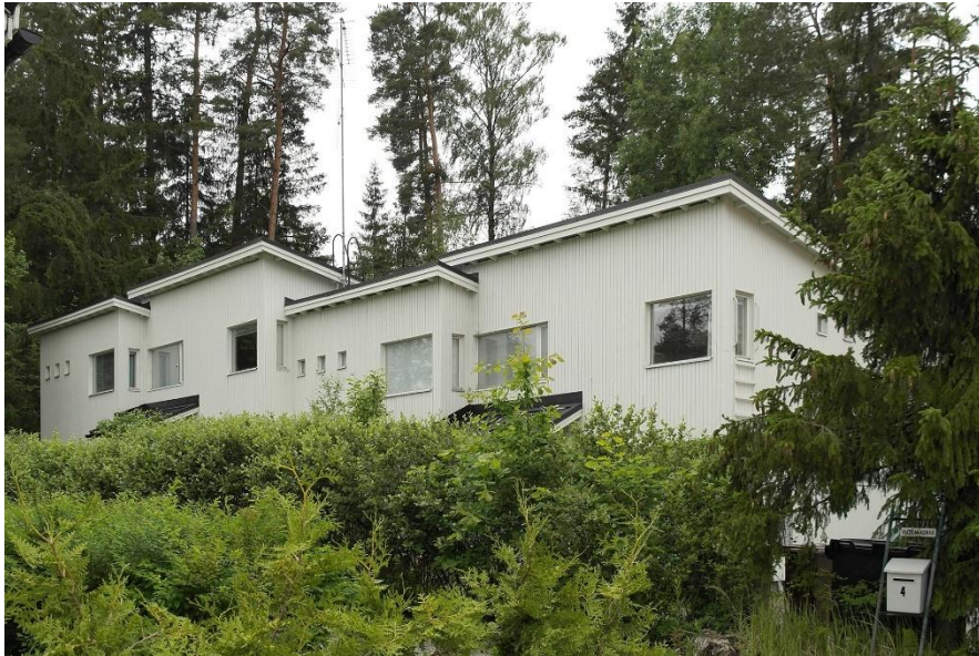
Rakennuksen itäistä julkisivua kuvattuna Sakarintieltä. Kuva: Venla Härmä, Vantaan kaupunginmuseo 2025.
