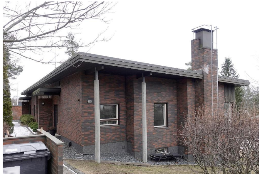
Rakennuksen länsipääty. Kuva: Juho Saloheimo, Vantaan kaupunginmuseo 2025.
