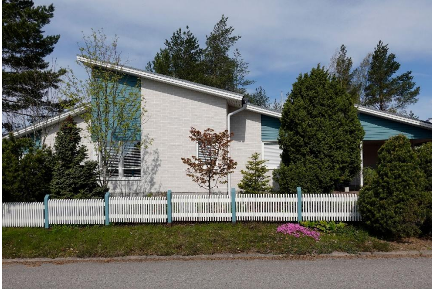
Tanssijantie 6, Ilola, suunnittelija Sera Honkavaara, 1994. Kuvan kohteen lupakuvissa julkisivujen vaakalaudoituskentät oli merkitty vaalean harmaiksi. Maalatut laudoituspinnat on mahdollista maalata aina uudestaan kulloisenkin asukkaan mieltymysten mukaiseksi. Kuvan rakennuskokonaisuutta täydentää julkisivun kanssa samoilla sävyillä maalattu aita. Kuva: Juho Saloheimo, Vantaan kaupunginmuseo 2025.
