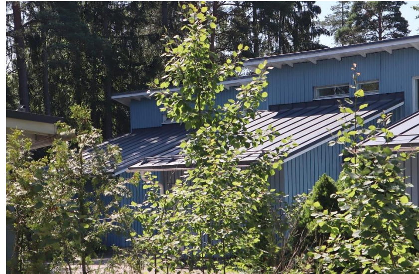
Rakennus 3 (taaimmainen sininen rakennus kuvassa) kuvattuna Aurinkomäentieltä. Kuva: Kristian Tuomainen, Vantaan kaupunginmuseo 2025.
